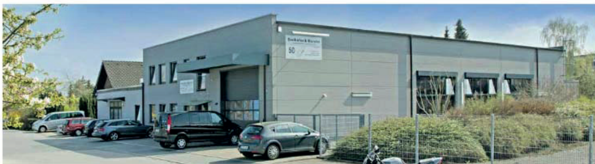
Firmengelände der Fa. Seehafer & Marohn GmbH & Co. KG in Velbert
